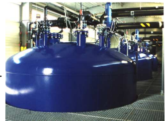
Reaktionsbehälter der biologischen Reinigungsstufe
